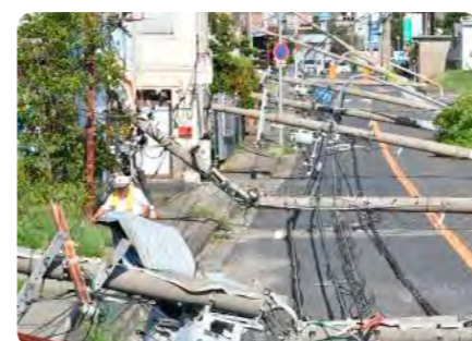
台風21号による強風でたおれた電柱 (2018年9月5日・大阪府和泉南市)
