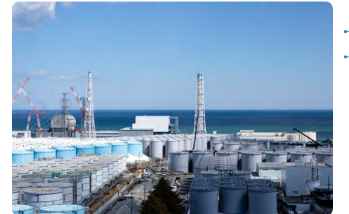
汚染水は、ALPS(多核種除去設備)と呼ばれる浄化設備などで浄化処理を行ったのち、タンクに保管している。保管している「処理水」の中には浄化設備では取り除けない「トリチウム」などが含まれている。【処理水】の取り扱いについては、科学的な観点からだけでなく風評被害など社会的な観点も踏まえて議論を行っている。 写真提供: 東京電力HD株式会社(2019年4月9日撮影)
