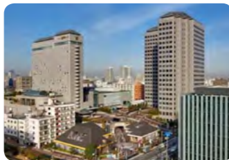
高効率ガスコージェネレーション発電機を導入し、発生した電力や熱エネルギーを施設全体で活用(東京イースト21)
