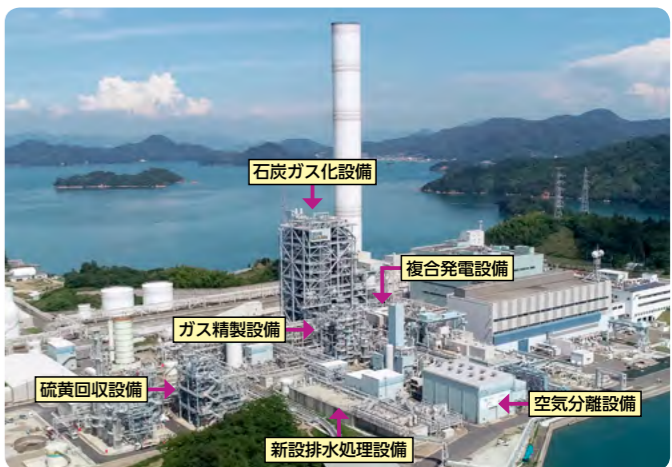
大崎クールジェンプロジェクト IGFCの実証試験が進められている大崎クールジェンのプラント設備。現在は第1段階のIGCC実証試験を終了。第2段階では二酸化炭素を分離・回収する実証試験、更に第3段階では燃料電池を加えた実証試験を予定している。(広島県大崎上島町) 写真提供：大崎クールジェン株式会社
