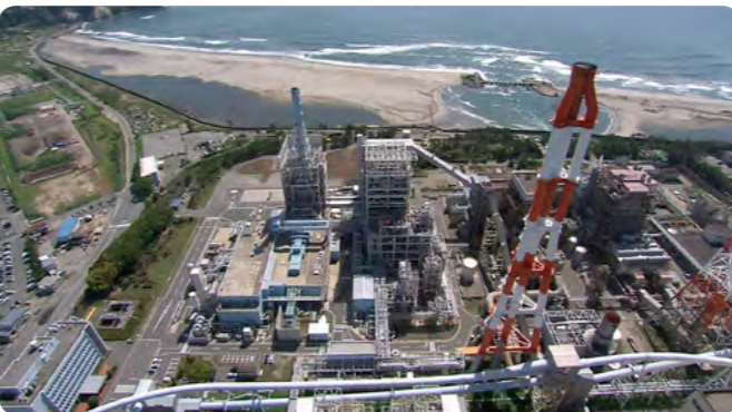
なこそ 勿来発電所10号機 日本初のIGCCによる発電所。2007年から実証実験を続け、2013年より商用運転中(出力25万kW)。現在の発電効率は42%程度だが、将来は燃焼温度を現在の1200℃から1500℃以上に引き上げて発電効率を48~50%まで向上させる計画である。 (福島県いわき市) 写真提供：常磐共同火力株式会社
