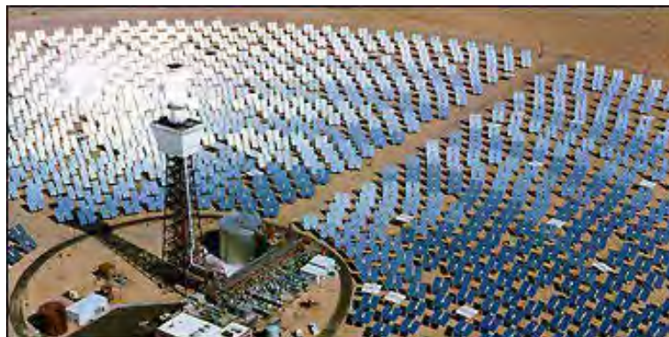
カリフォルニア州の砂漠に設置された太陽熱発電所
