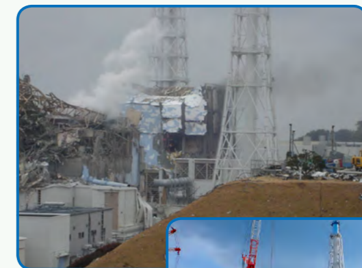
▲事故後の東京電力福島第一原子力発電所
