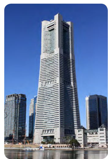
石炭の灰をふくんだコンクリートを使用した「高層ビル(横浜ランドマークタワー・神奈川県横浜市)」
