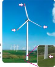
鳥が遠くからでも風車に気がつくよう、プレードやタワーの下部に目立つ色をペイントした風車。
