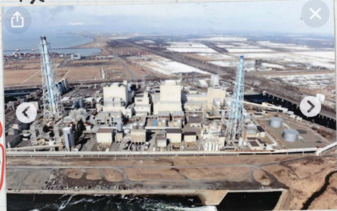
とまどう厚真火力発電所
