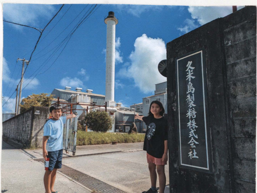
製糖工場の前 (バイオマス発電所)
