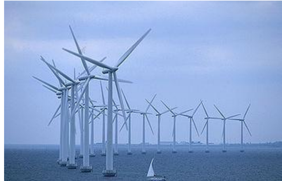
ミドルグロン洋上風力発電所
