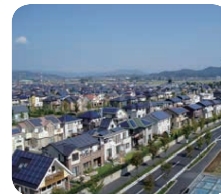
太陽光発電システム実証試験地区（群馬県太田市PalTown城西の杜）
