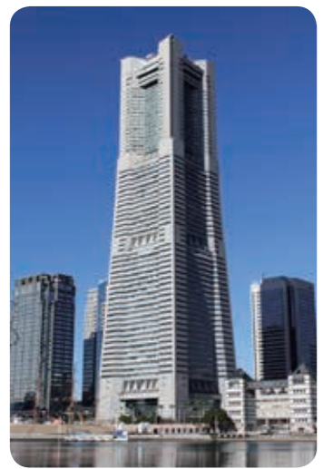
石炭の灰をふくんだコンクリートを使用した高層ビル（横浜ランドマークタワー・神奈川県横浜市）
