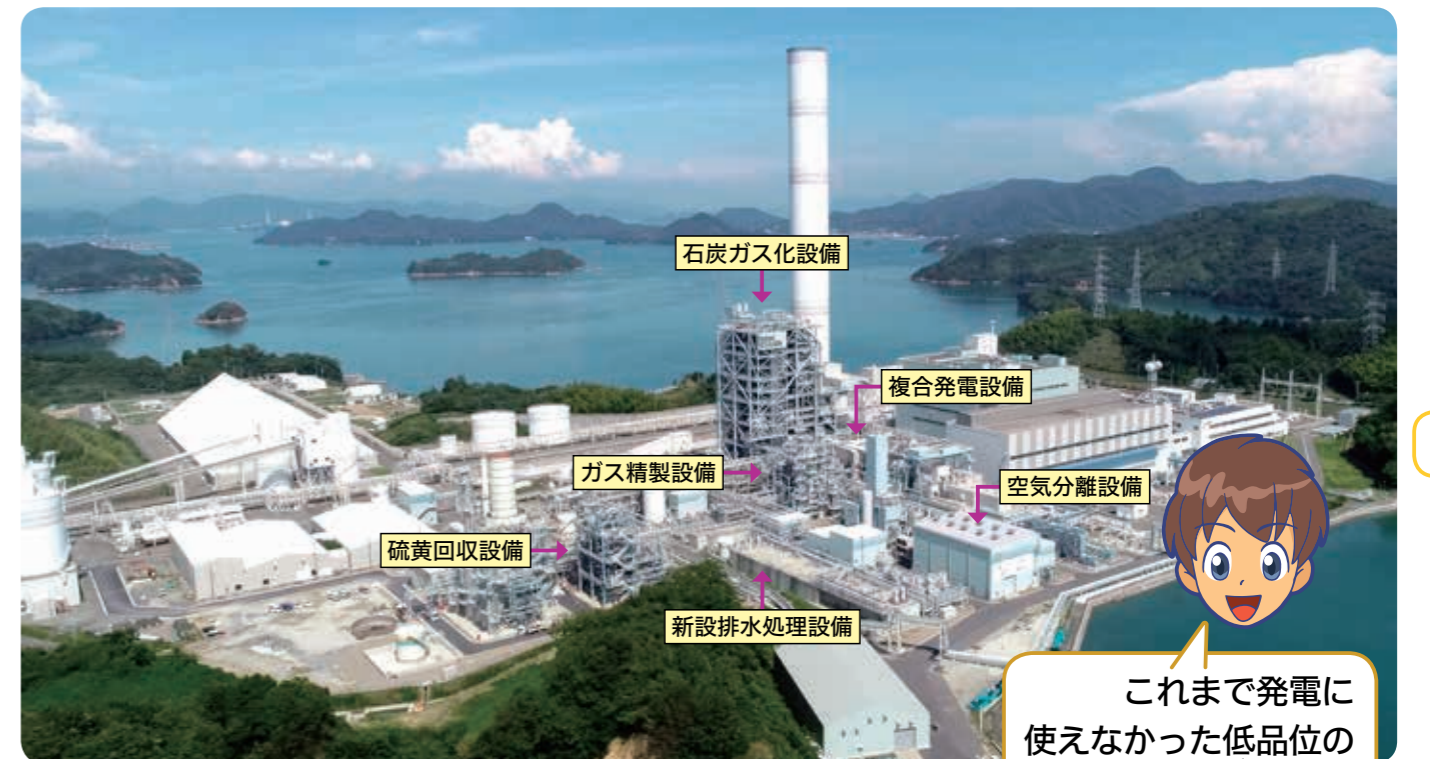
大崎クールジェンのプラント設備（広島県大崎上島町）
