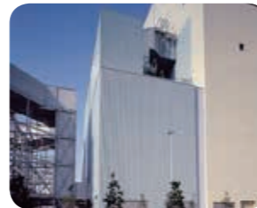
▲排煙脱硝装置
