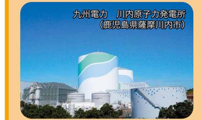
原子力発電所
