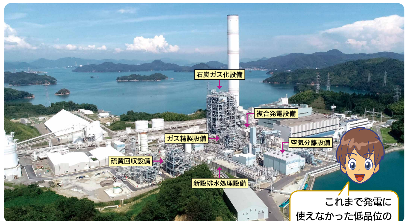
大崎クールジェンのプラント設備（広島県大崎上島町）
