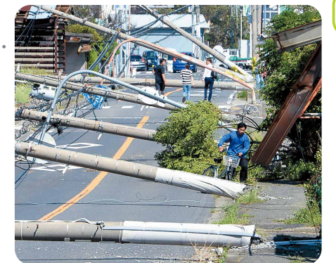
台風21号による強風でたおれた電柱 (2018年9月5日・大阪府泉南市)
