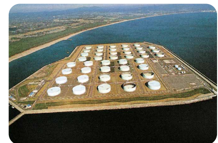
志布志国家石油備蓄基地(鹿児島県)
