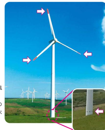
鳥が遠くからでも風車に気がつくよう、ブレードやタワーの下部に目立つ色をペイントした風車。
