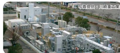
水素100%による電気・熱供給(兵庫県神戸ポートアイランド) 2018年、水素燃料100%のガスタービン発電による電気と熱の供給を世界で初めて市街地でおこなった。電力や熱は近隣の病院などの施設へ供給されている。
