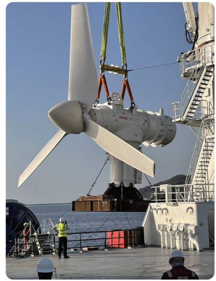
長崎県五島列島付近に設置する潮流発電機 写真提供: 九電みらいエナジー株式会社
