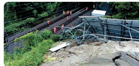
災害による太陽光発電設備の被害例(写真出所) 資源エネルギー庁「日本のエネルギーを知る10の質問」
