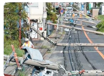
台風21号による強風で倒れた電柱 (2018年9月5日・大阪府泉南市)
