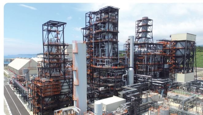
広野IGCC発電所 IGCCを採用した最新鋭の石炭火力発電所 (福島双葉郡)。福島復興に向けて2021年11月に運転が始まった (出力54.3kW)。発電効率約48%と世界最大の高効率を実現。従来型石炭火力発電とくらべ、二酸化炭素排出量を約15%低減している。 写真提供：広野IGCCパワー合同会社
